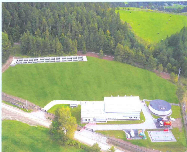
Stacja uzdatniania wody „Jasieńczyk”
